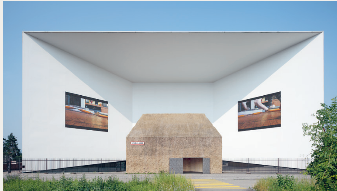
Eingangsbereich mit Torhaus und LED-Bildschirmen
